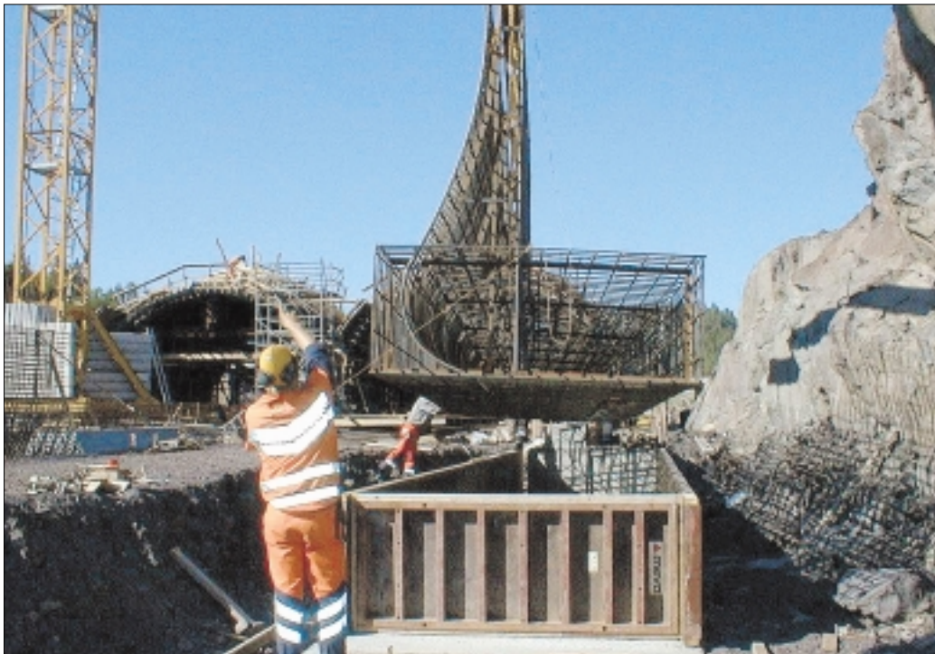
Ferdig bundet armeringskurv heises på plass i fundamentforskalingen.
