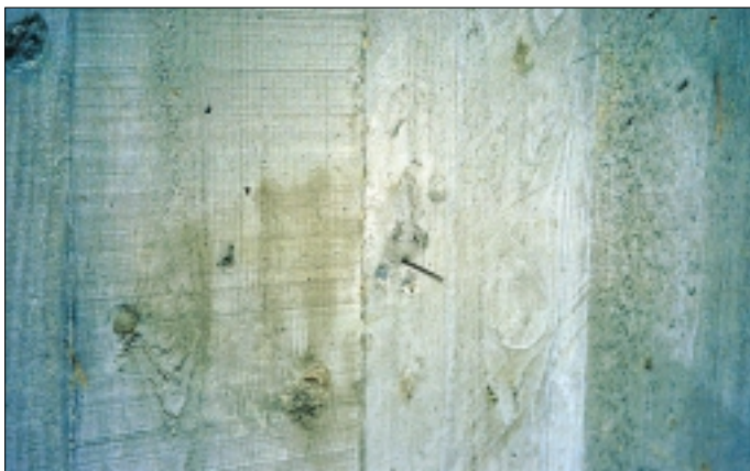
Forskalingens bordmønster og trestruktur blir perfekt gjengitt i den vibreringsfrie betongens overflate
